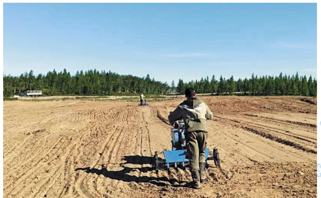
Рекультивация площадки скважины № 53 Тагульского лицензионного участка
